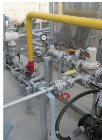
据付配管工事
