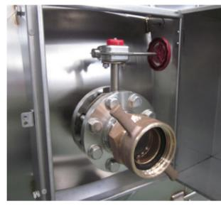
災害時に消防車と接続し、タンクの水を消火用として取り出せます。
