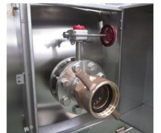
火災時には防火用水としても使えます。地下に埋設する防火水槽と違い、水の管理も容易で消防ホースの接続口があるので取水も簡単です。
